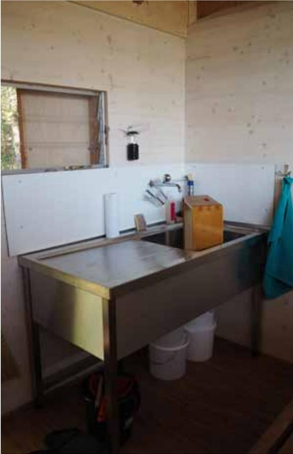
Grosser Waschtrog. Dachwasser wird aussen in einem Tank aufgefangen und zum Wasserhahn über dem Waschtrog geleitet.
